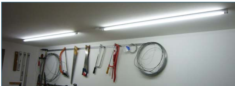
Abb. 3: Weiße glatte Wände und Decken für eine ganzräumliche Ausleuchtung ohne Reflektoren
